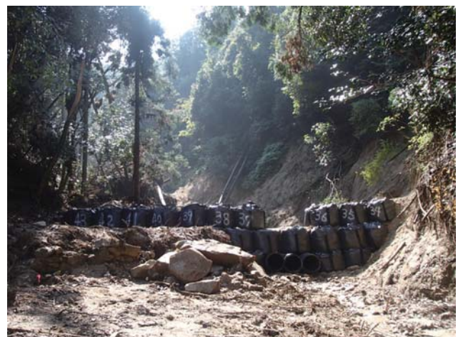
大型土嚢の設置による応急対策
