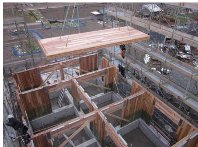
CLTで建設中の共同住宅(岡山県真庭市)
