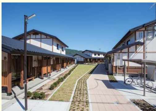
災害公営住宅(木造長屋1~2階建て)
