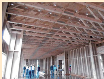
工場棟(福井県福井市)
