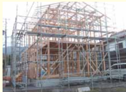
木造の復興住宅の建設
