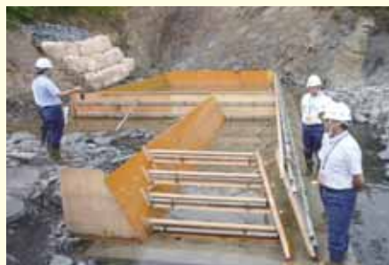
国産材型枠用合板の使用現場
