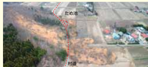
山腹崩壊の状況
