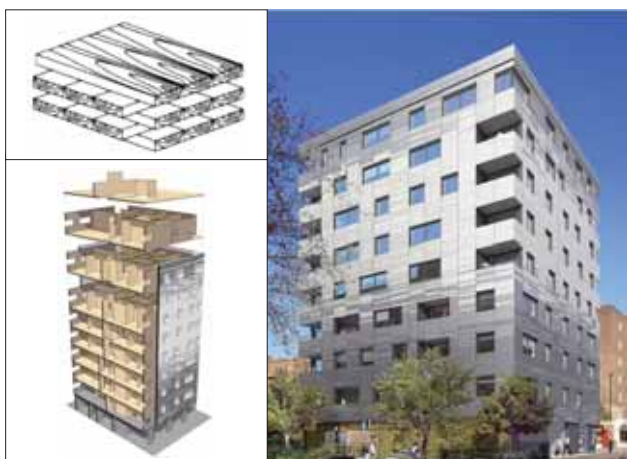
CLT を用いて建築された集合住宅（英国ロンドン） （木造9階建て。ただし、1階部分は鉄筋コンクリート造）
