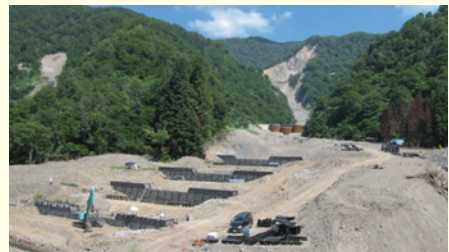
復旧工事の様子
