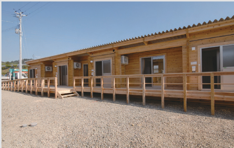
木造で整備された応急仮設住宅(福島県会津若松市)
