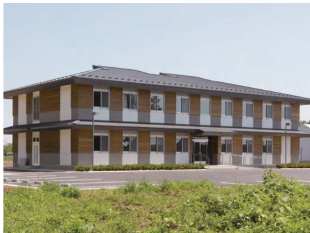
木造で整備された公共建築物 (横浜植物防疫所つくばほ場)
