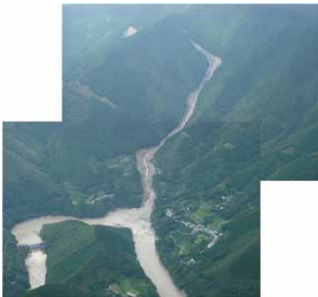
台風第6号に伴う豪雨による被害（高知県北川村 きたがわむら ） 山腹崩壊により国道等が被災。
