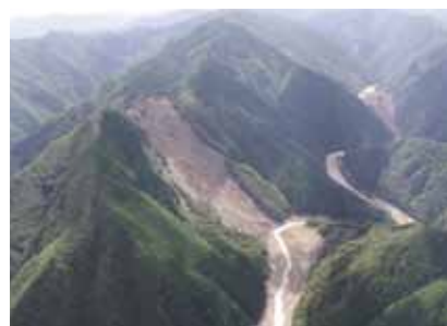
台風第12号に伴う豪雨による被害 (奈良県五條市)
