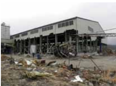
合板工場の被災状況 (岩手県宮古市)
