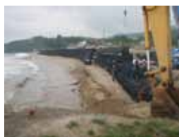
大型土のうによる 緊急対策工事
