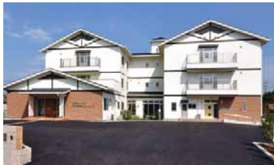
平成22(2010)年7月に、岡山県玉野市<sup>たまのし</sup>で建築された特別養護老人ホーム。国内最大級の在来工法による木造耐火建築物で、地域材を多用。
