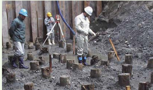
あすわ さいわい 足羽川（福井県）の幸橋の基礎として74年間地中にあった木杭（マツ属）の杭頭部分。木杭は極めて健全であることがわかった。
