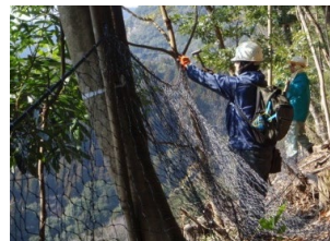
〔 防護柵等の設置による 造林木や植生の保護 〕
