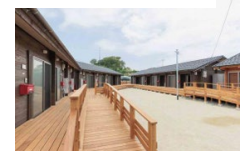
令和6年能登半島地震 (石川県輪島市)
