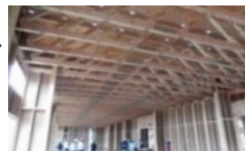
製材による大規模トラス
