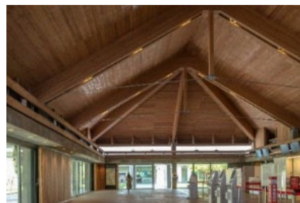
空港（沖縄県宮古島市）
