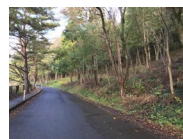
整備後の様子
