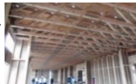
製材による大規模トラス
