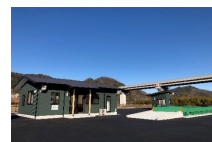
管理棟・トラックスケール
