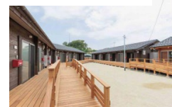
令和6年能登半島地震 (石川県輪島市)
