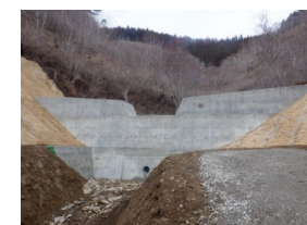
治山事業による 土砂流出防止対策
