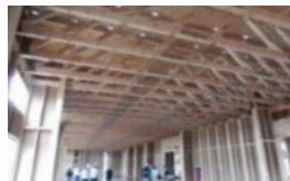
製材による大規模トラス
