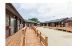
令和6年能登半島地震 (石川県輪島市)
