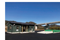
管理棟・トラックスケール
