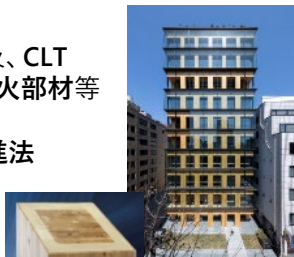
木造11階建て 研修施設 (2022年竣工) 木質耐火部材
