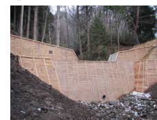
治山事業の残存型枠での間伐材利用 (岩手県宮古市)
