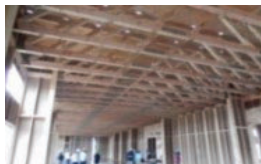
製材による大規模トラス
