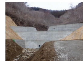
治山事業による土砂流出防止対策
