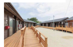
令和6年能登半島地震 （石川県輪島市）
