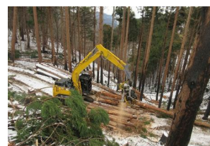
森林災害復旧事業による 被災木の伐採
