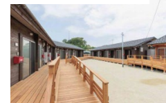
令和6年能登半島地震 (石川県輪島市)
