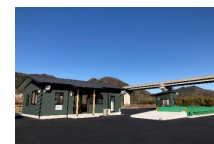
管理棟・トラックスケール
