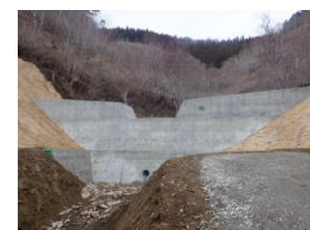
治山事業による 土砂流出防止対策
