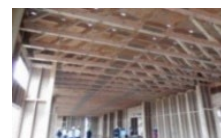
製材による大規模トラス
