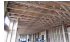
製材による大規模トラス
