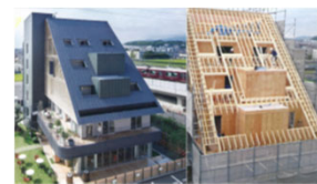
木造非住宅建築物 (※JAS構造材を活用した商業ビル)
