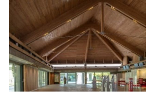
空港(沖縄県宮古島市)
