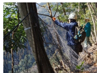
防護柵等の設置による シカ被害防止対策の推進
