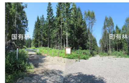
国有林と民有林を連結した林業専用道
