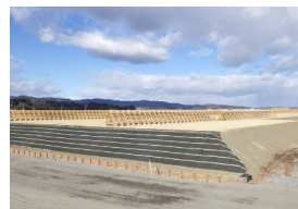
生育基盤盛土の造成による機能向上
