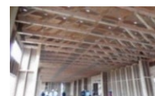
製材による大規模トラス
