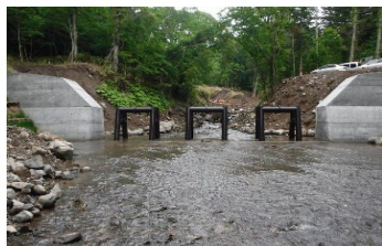
〔山腹工 (九州森林管理局佐賀森林管理署)〕 〔流木補足式治山ダム工 (北海道森林管理局後志森林管理署)〕 〔令和6年能登半島地震発生後の ヘリコプター調査〕
