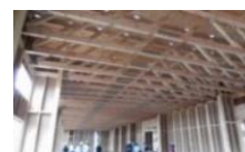
製材による大規模トラス
