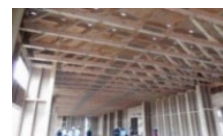
製材による大規模トラス
