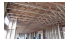
製材による大規模トラス
