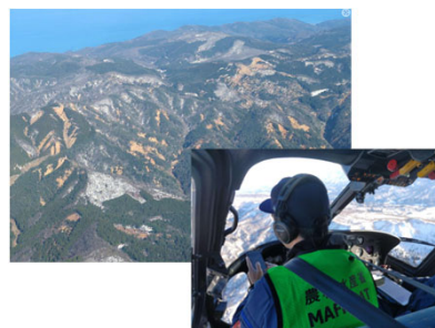
〔令和6年能登半島地震発生後の ヘリコプター調査〕
