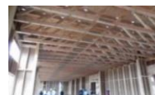
製材による大規模トラス
