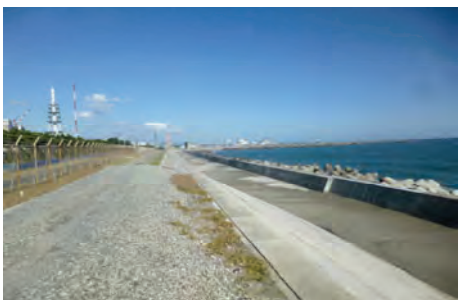
⑤施工後5年経過
