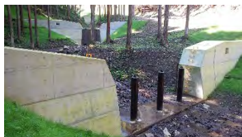
流木捕捉式治山ダムを設置
