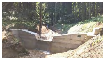
5 土砂流出を防止する治山ダム群の整備
