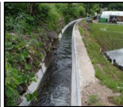
老朽化した用水路の整備・更新
