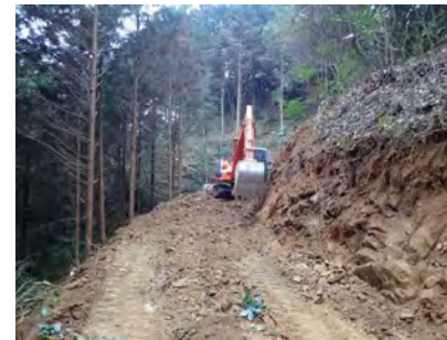
森林作業道整備
