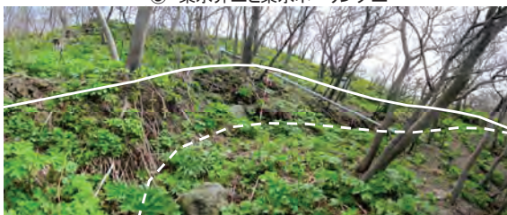
④ 地すべりによる段差地形
