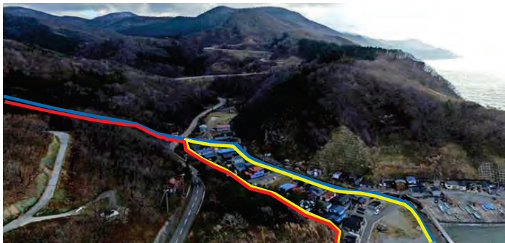
① 保全対象(人家、国道338号)
