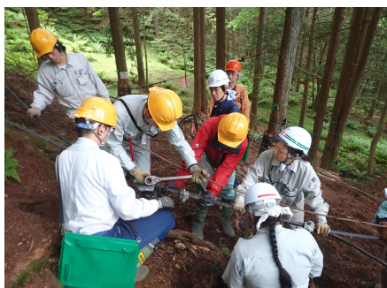
架設作業(主索の固定)
