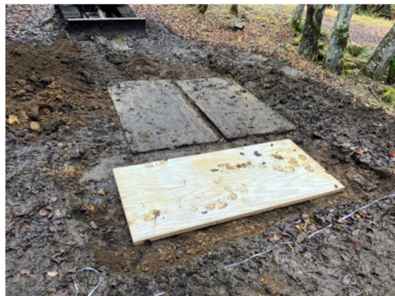
図-6 厚さ 48mm の構造用合板による施工（掘り出した構造用合板の上に直置き）
