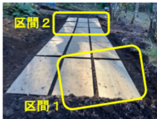
図-1 改修対象とした施工区間の構造用合板の施工状況（2022年10月31日撮影）
