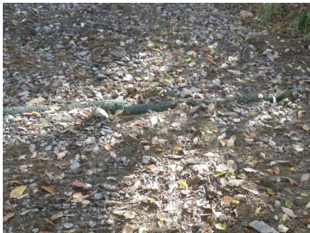
樹脂製疎水材の素掘への埋め込み (B)
