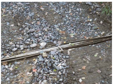
竹束の素掘への埋め込み (C)
