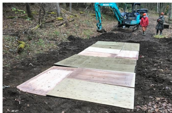
写真 1 構造用合板の敷設状況（埋戻し直前） （掘削深さ 100mm、2020 年 11 月施工）
