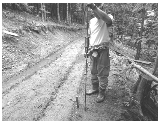
図－３ 貫入試験器による計測
