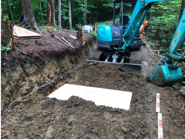
写真 3 幅員 2.5m の作業道における施工試験 (区間 C、敷設した合板の埋戻し作業中)
