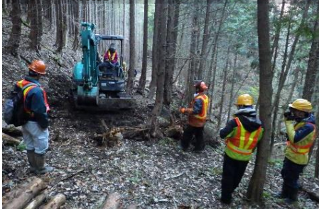
伐根や表土も利用しながら作業を進めていく
