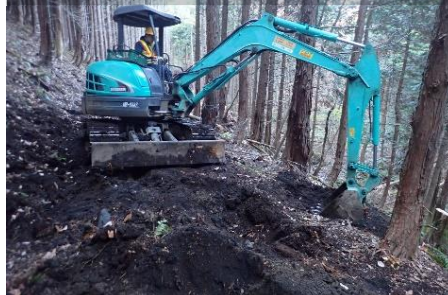
路体が崩れないように、盛土はしっかりと締め固める
