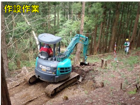
路体が崩れないように、床掘は丁寧に行う
