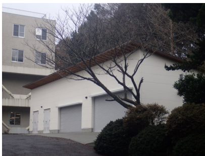
完成した木造平屋建ての倉庫兼車庫
