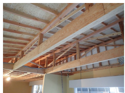
LVLの長スパン利用と構造用合板の野地板
