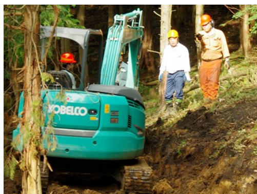
オペレータ役の研修生に指導者役の研修生が切取箇所を指示
