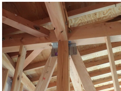
木造軸組工法（ホゾと短冊金物）による施工
