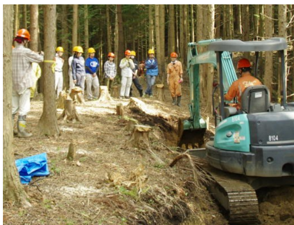
森林作業道作設作業を見学
