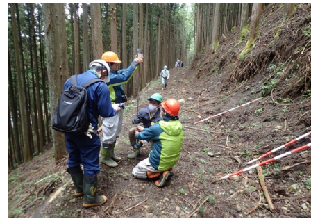
路体構造調査（貫入試験）の現地実習
