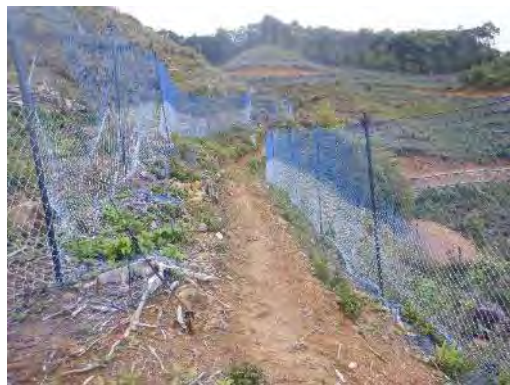
図1：ブロックディフェンスによるシカ防護柵の施工（高知県幡多郡三原村）
