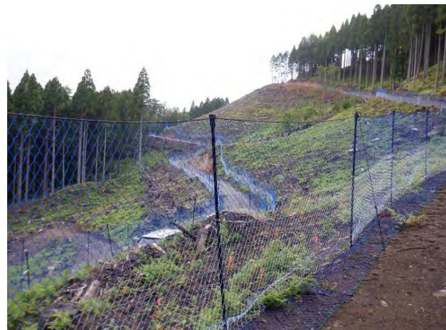
図1：ブロックディフェンスによるシカ防護柵の施工（兵庫県宍粟市）
