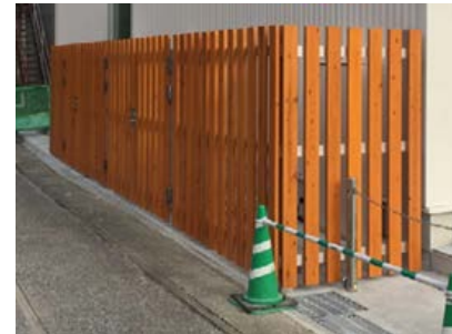
四国森林管理局嶺北署外構フェンスにCNF塗料を試験塗装
