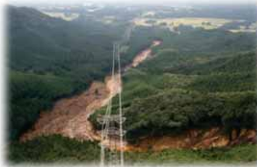
平成27年 線状降水帯による災害 (日光市 岩崎 白石川)
