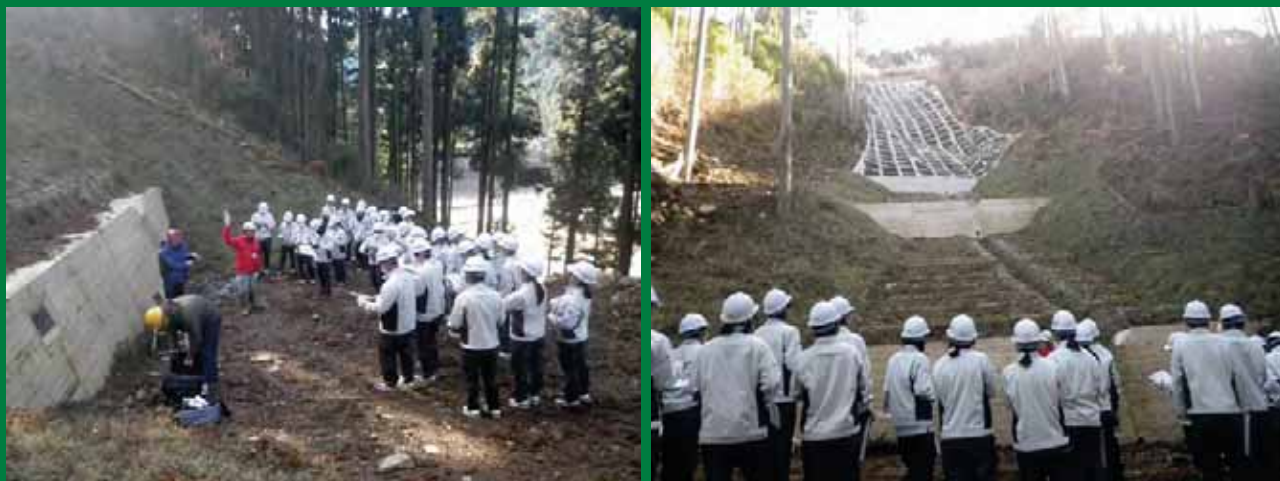
鹿沼市引田「長安寺」・山腹工（土留工）
