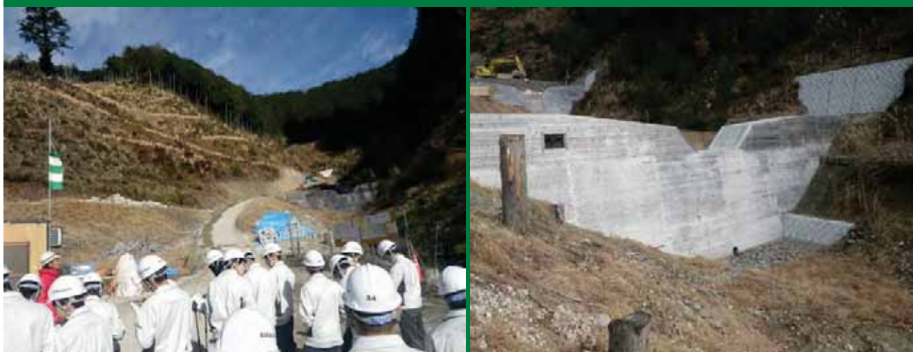
鹿沼市下粕尾「宮沢」・溪間工（谷止工）
