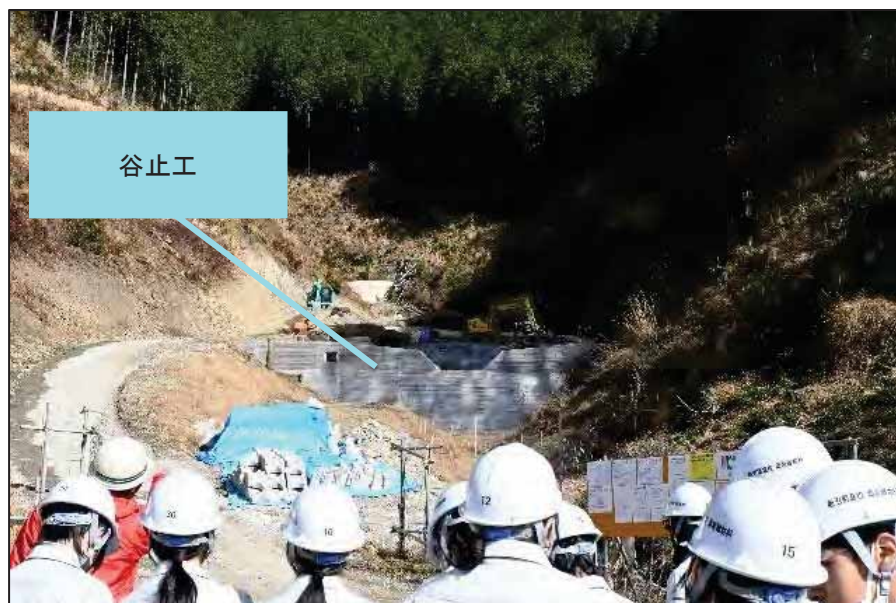
【写真】治山施設（谷止工）を全体的に見学、説明を聞いている様子
