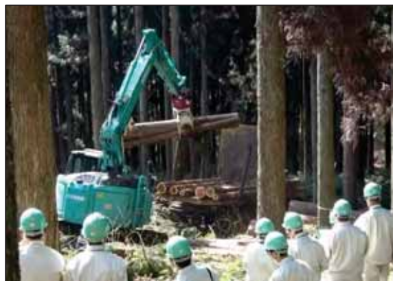
【写真】フォワーダへの材の積み込みを見学
