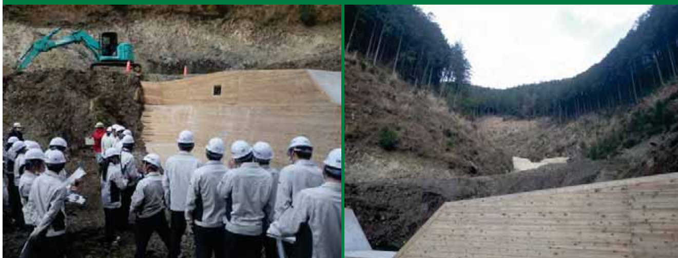
鹿沼市下粕尾「宮沢」・溪間工（谷止工）
