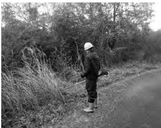
林道沿いの草刈り作業の様子
