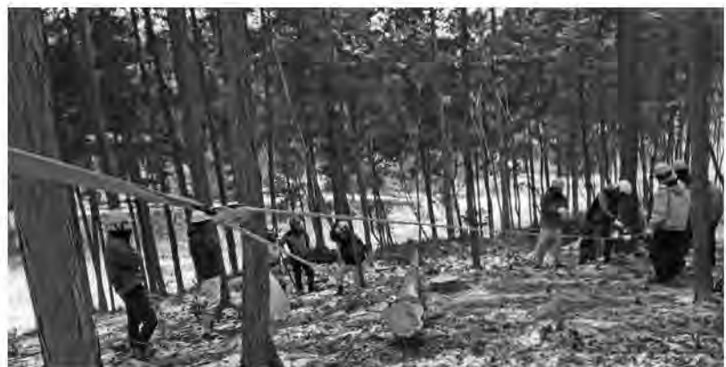
▲▲簡易ウインチ（ポータブルキャブスタンウ インチ）による搬出作業
