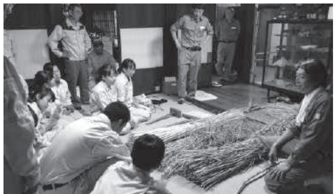
合掌屋根の葺替作業をする職人から茅葺き屋根の材料を説明してもらう
